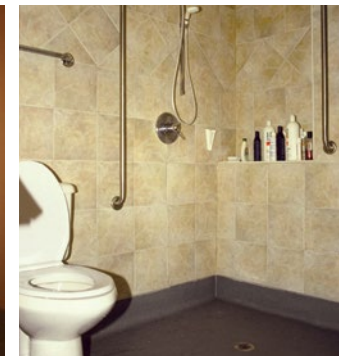
Figure 11: Toilette avec espace suffisant pour le transfert Photo: Ron Wickman
