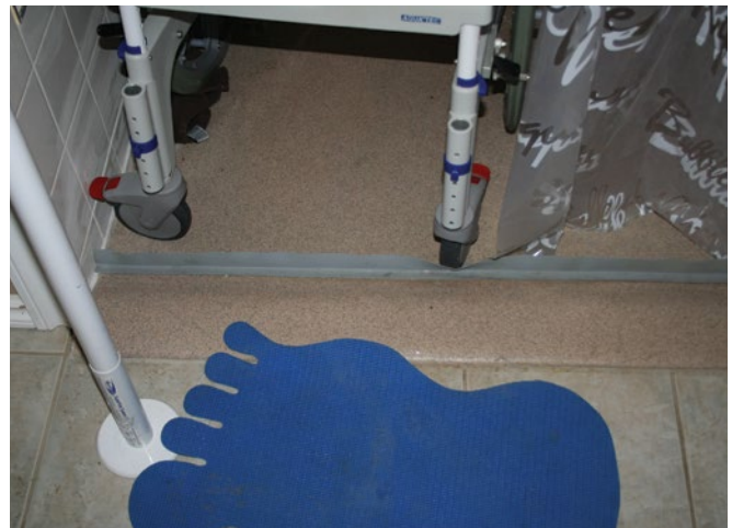
Figure 5: Membrane étanche à l'entrée de la douche
